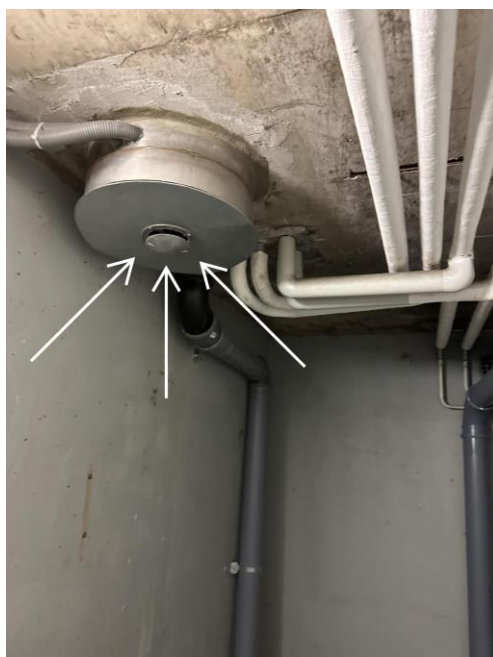
Sopnedkast/frånluft i soprum.
